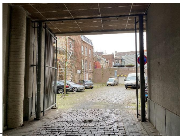
Foto 2: onderdoorgang gezien vanaf het achter terrein
