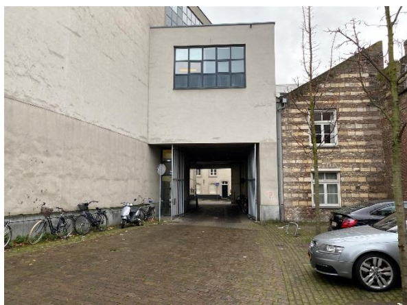
Foto 1: onderdoorgang gezien vanaf het achter terrein
